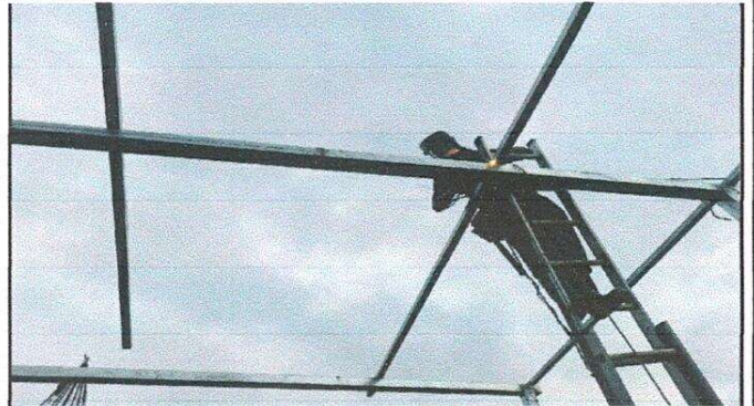
Foto 2: Colocación y soldadura de estructura metálica.
