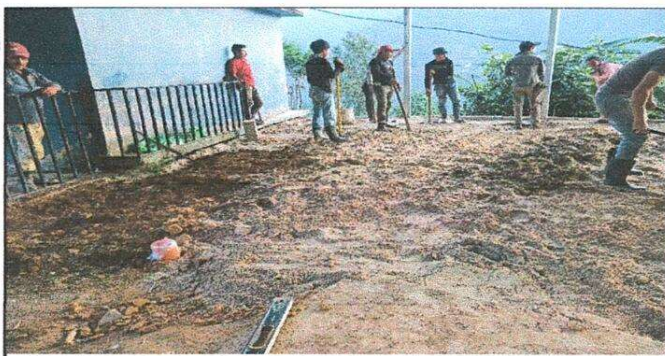
Foto 5: Nivelación de terreno antes de fundición de concreto.
