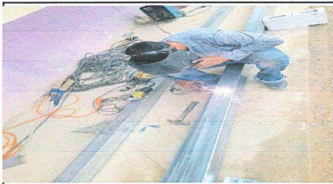
Foto 1: Soldadura de estructura metálica.
